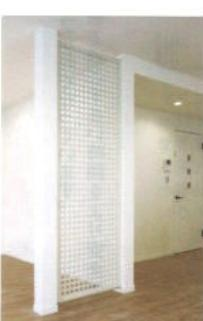
パンチングメタルを使用した透光型の耐力壁。光や風を通してながら、耐震リフォームができます。
